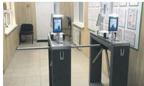
На контрольно-пропускном пункте при въезде на территорию РММ Виноградовского леспромхоза установлено оборудование, при помощи которого пропуск будет возможен лишь с распознаванием лица сотрудника. Руководством ГК «УЛК» принято решение установить метод фейс-контроля на всех предприятиях холдинга. Ранее внедренное в Устьянском ЛПК такое же оборудование зарекомендовало себя с положительной стороны.
